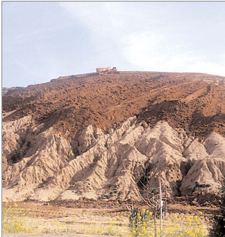
Versante ionico del catanzarese. L'eliminazione meccanica di solchi erosivi (rill o gully erosion) è di scarsa efficacia senza adeguate tecniche di gestione dei suoli.
