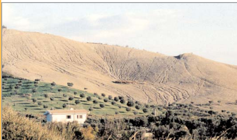
S. Maria di Catanzaro - Gravi danni da erosione incanalata
