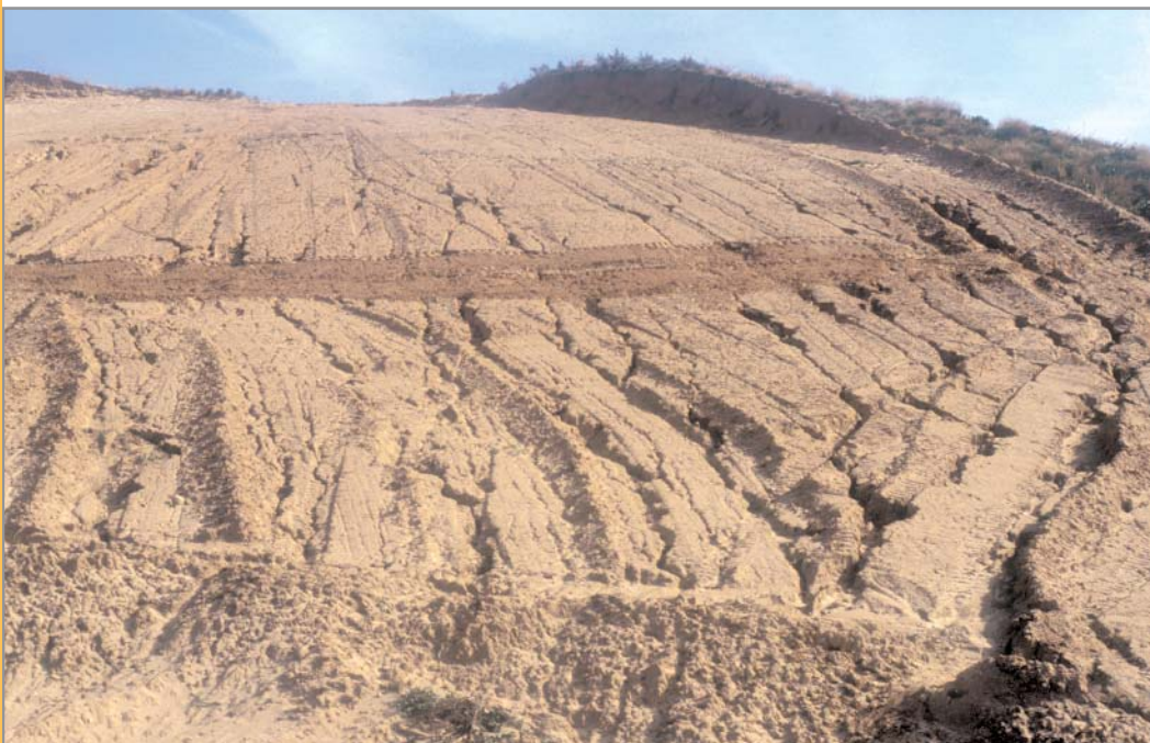
Il modellamento dei versanti altera l'idrologia superficiale causando spesso fenomeni di erosione incanalata
